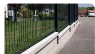
P.84 - Dalle béton
