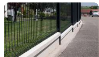
P.84 - Dalle béton
