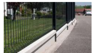
P.86 - Plaque de soubassement béton pour gestion des redans
