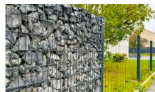
P.104 - Clôture gabion
