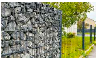
P.104 - Clôture gabion
